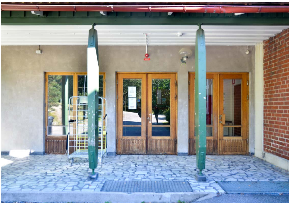
Bild 57. Kolonnad av målade limträbjälkar med spetsiga avslut. SLM D2022-0404.
