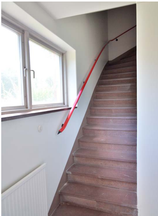
Bild 76. Kalkstenstrappa med järnräcke i hölje av röd plast. Bilden är tagen vid den f.d. biblioteksingången. SLM D2022-0423.
