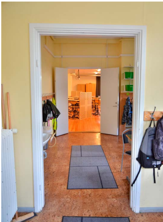
Bild 41. Äldre dörrfoder, men dörren har tagits bort. Längst bort syns klassrummet i slöjdhusetets södra del. SLM D2022-0388.
