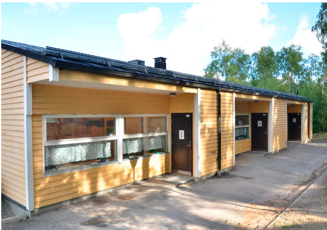
Bild 9. ... kontrasteras av tillbyggnadens östra fasad, där förhållandet är det omvända: burspåken är indragna medan de oglasade hallpartierna "står ut". SLM D2022-0356.
