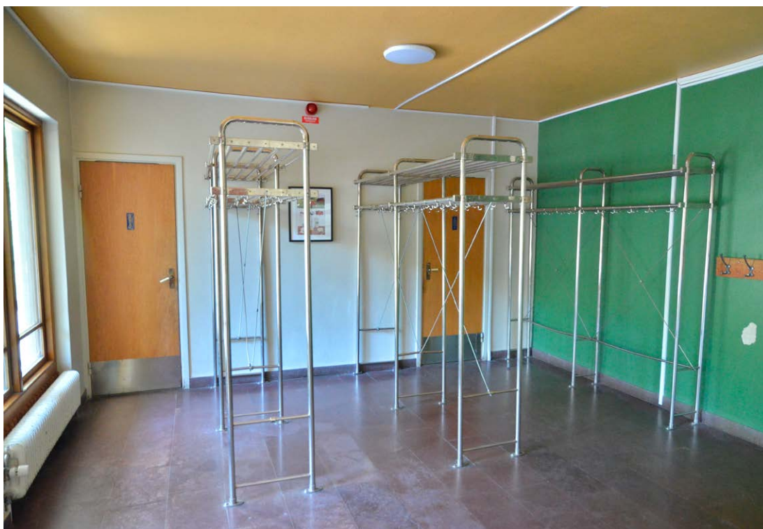
Bild 65. Foajén med rött kalkstensgolv, fönsterbågar av ek, kromade klädhängare och fernissade trädörrar till WC. SLM D2022-0412.
