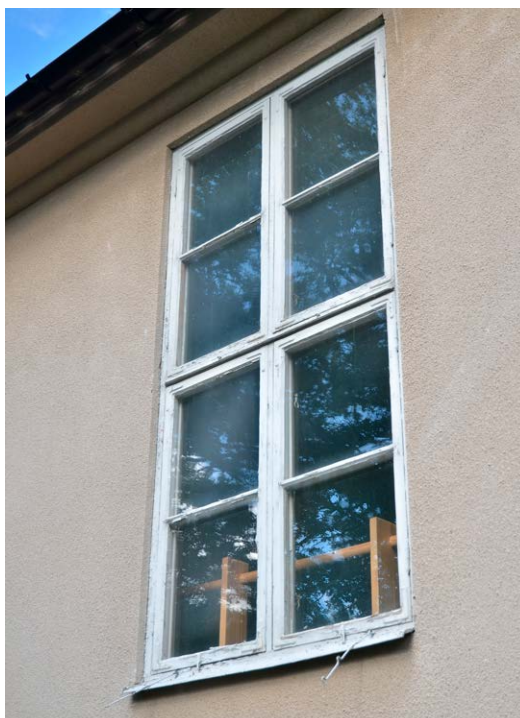
Bild 23. De ursprungliga träfönstren och spröjsindelningen är viktiga för byggnadens karaktär. SLM D2022-0370.
