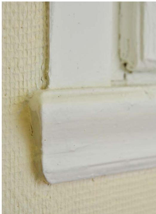
Bild 34. Ursprungliga profilhyvlade fönsterfoder. SLM D2022-0381.
