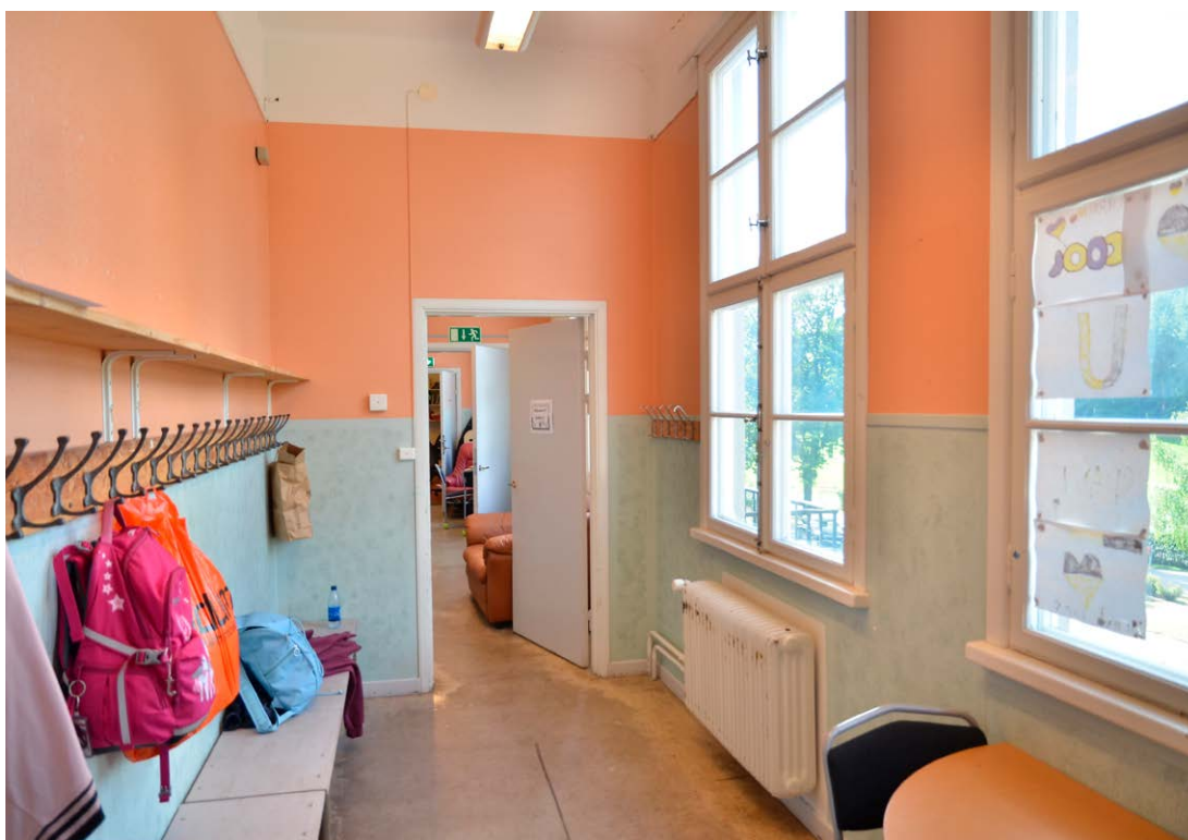
Bild 11. Vägg till vänster i bilden har tillkommit under senare tid. Takhöjden och de höga fönstren bevarar dock en äldre karaktär. De ursprungliga fönstren med spanjolettbeslag, hylade foder och lister samt klädkrokarna av gjutjärn är värdefulla. SLM D2022-0358.
