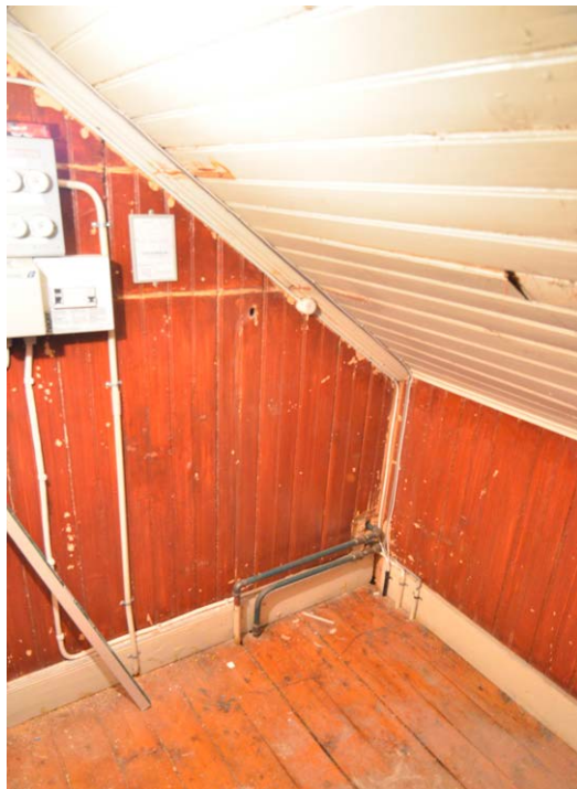
Bild 51. Inredd vind på västra sidan. SLM D2022-0398.
