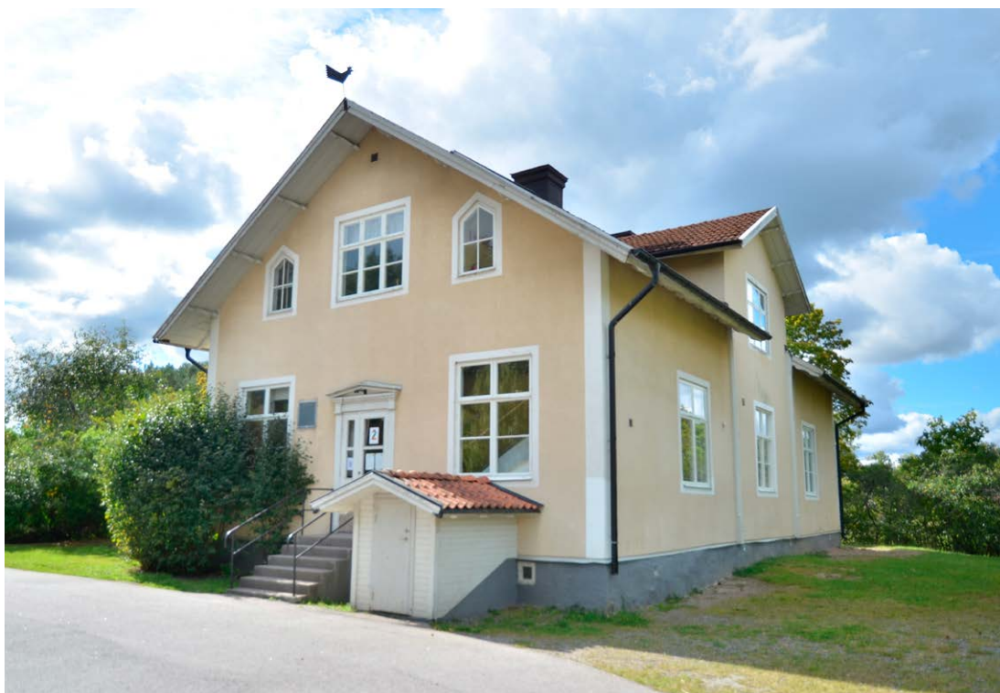
Bild 37. Slöjdhusets nordvästra fasader. SLM D2022-0384.
