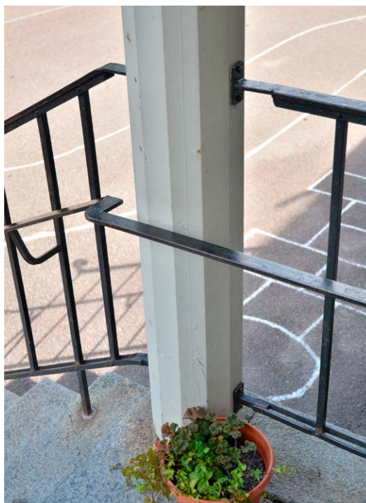
Bild 5. Målade träkolonner med släta räfflor (kannelyrer). SLM D2022-0352.
