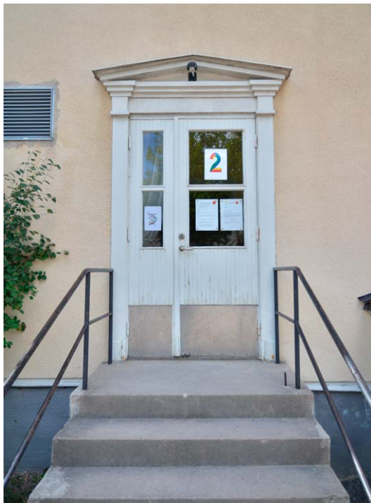
Bild 38. Huvudingången från norr. Dörren omfattas av en enkel men smakfull tempelgavel på pilastrar. SLM D2022-0385.
