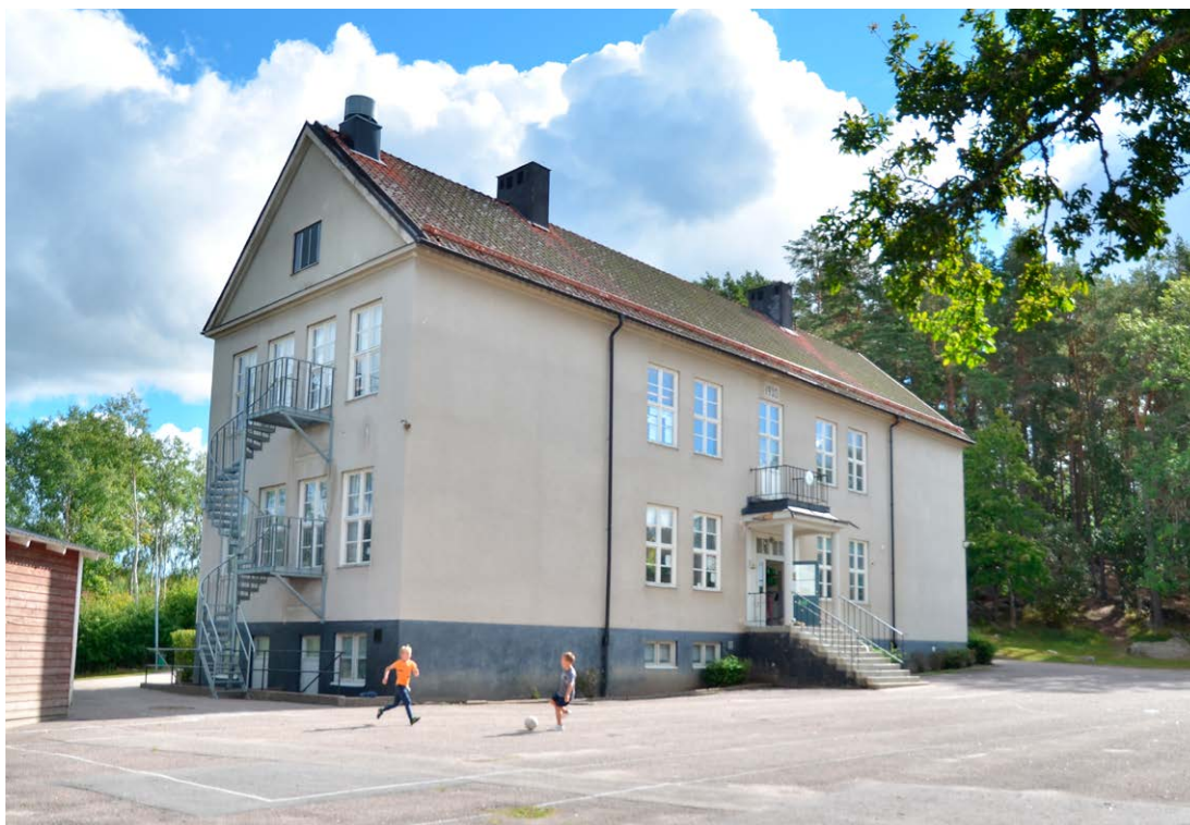
Bild 2. Skolhuset från 1930, vy mot nordöst. SLM D2022-0349.
