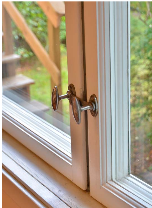
Bild 42. Klassrummets kopplade träfönster och vred är i mycket gott skick. SLM D2022-0389.
