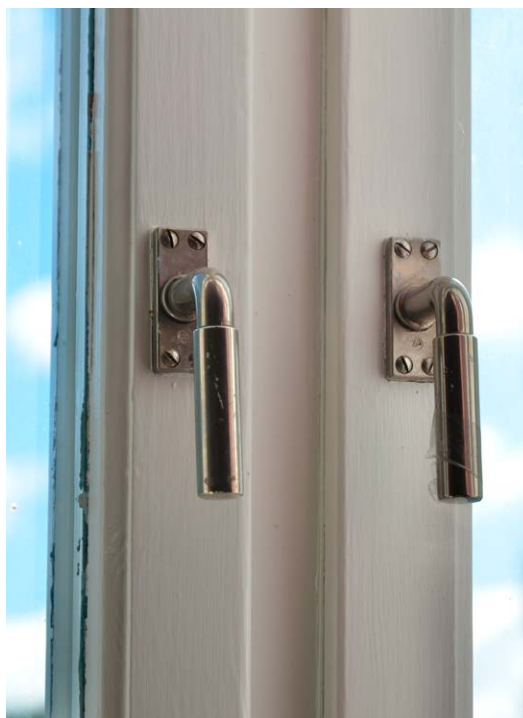
Bild 74. Andra våningens träfönster är i gott skick. Virkets proportioner och utförande är karaktärskypande. SLM D2022-0421.
