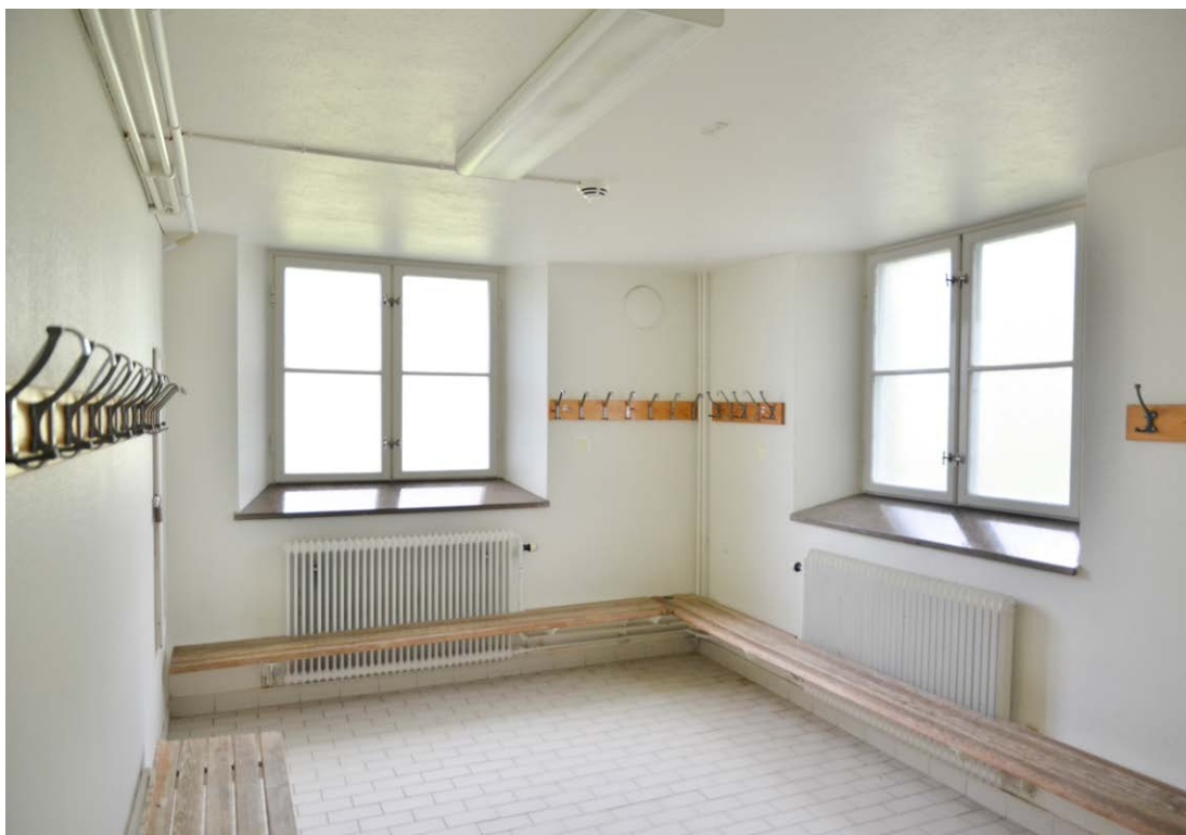
Bild 35. Omklädningsrum i nedervåningen. Notera fönsterbänkarna av röd kalksten, de äldre fönstren med beslag samt gjutjärnskrokarna till vänster i bilden. SLM D2022-0382.
