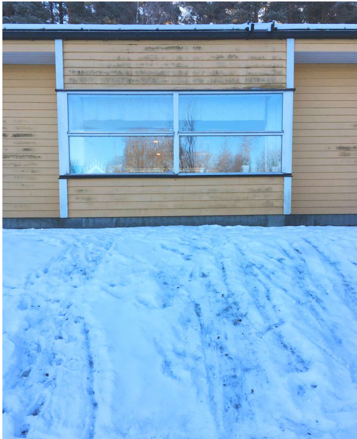
Burspråk på flygelbyggnaden. Spår i snön efter kanåkning. FOTO: Katarina Johansson
